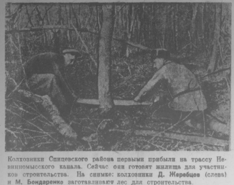
Колхозники Спасского района первыми прибыли на трассу Невинномысского канала. Сейчас они готовят ящики для участников строительства. На снимке: колхозники Д. Меребцов (слева) и М. Бондаренко заготавливают лес для строительства. Фото А. Добровольского.
