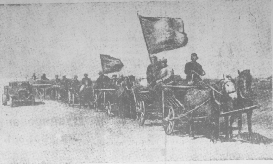
Сегодня начинаются массовые работы по завершению строительства Невинномысского канала. В них примут участие 25 тыс. колхозников...
