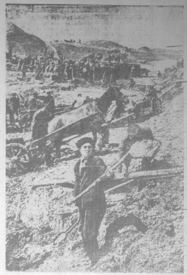
Строительство Невинномысского канала. Колхозники Шаповского района на очистке грунта. Фото Н. Шевцова.
