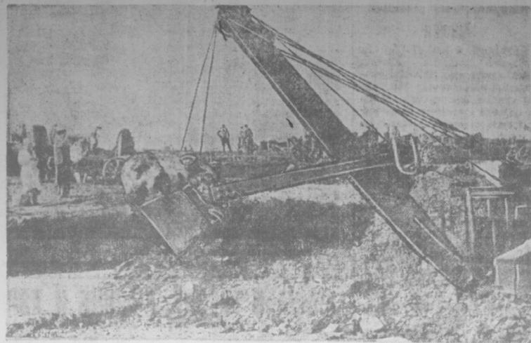
На строительстве Невинномысского канала. Экскаватор на выемке грунта. Фото С. Петросяна.
