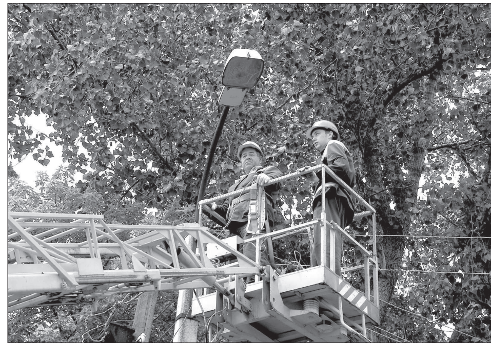
● Не каскадеры и не плотники, а электромонтеры-высотники.
