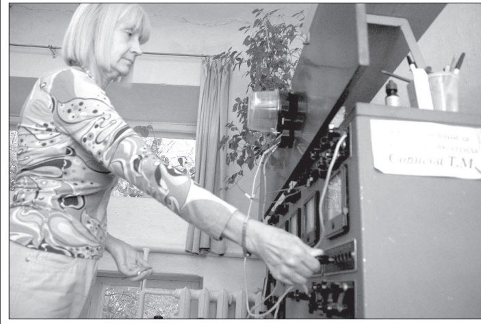
● Электрооборудование тщательно тестируется.
