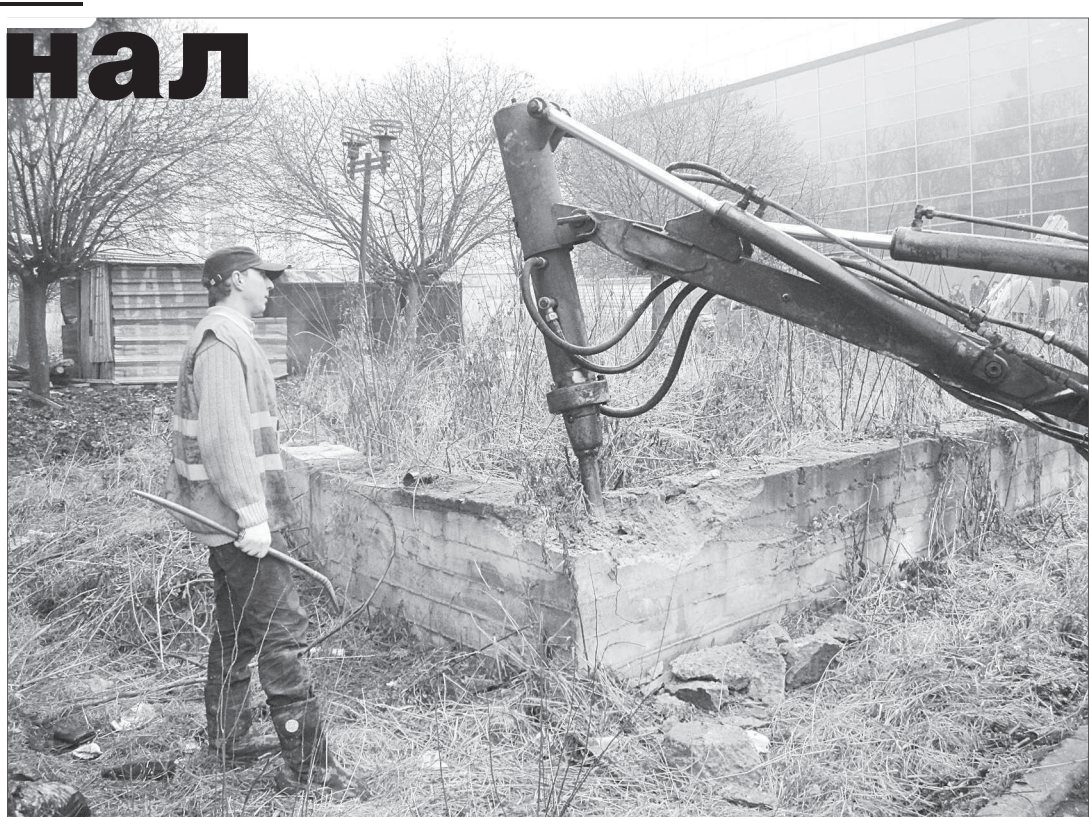
Снос фундамента недостроенного кафе.
