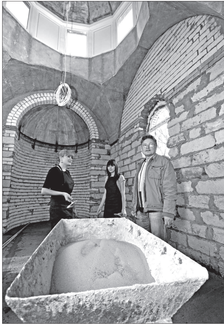
● Будущие прорабы второкурницы Аня ТОРОПЦЕВА и Алена ПОСЕВКОВА наносят первый слой штукатурки на стены часовни под руководством мастера производственного обучения Александра ПОВЕЛКО.
