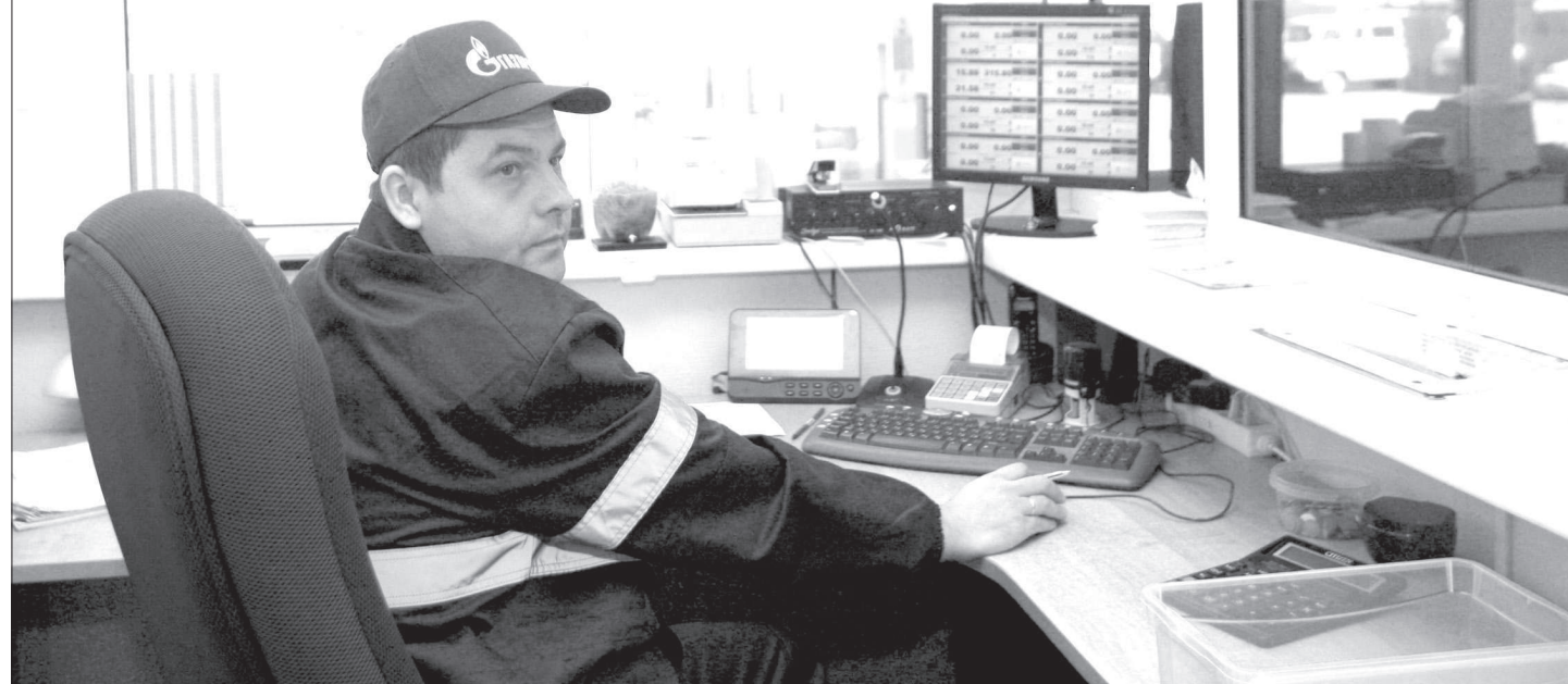
• В операторной АГНКС №1.
