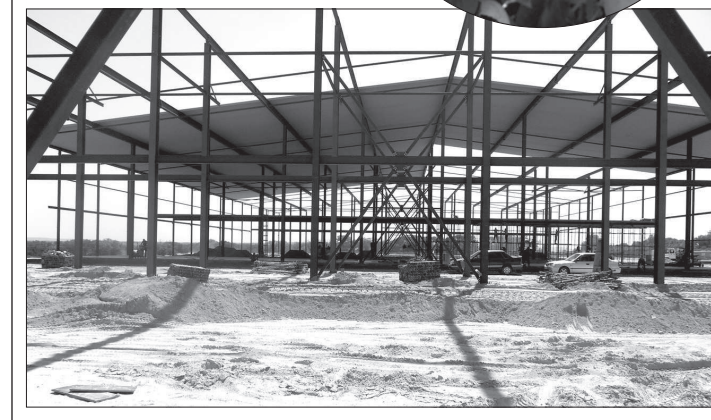
На строительство современного плодохранилища.
