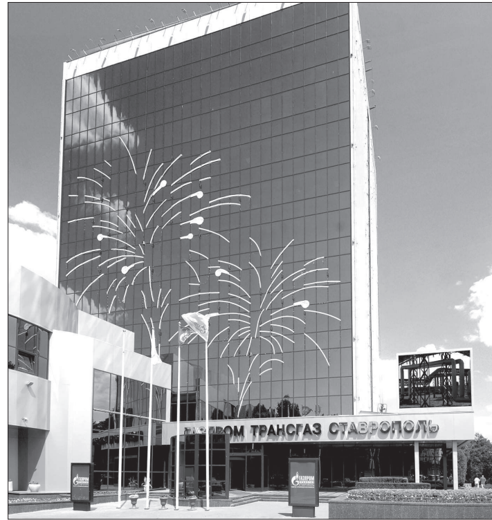
Здание ООО «Газпром трансгаз Ставрополь».
