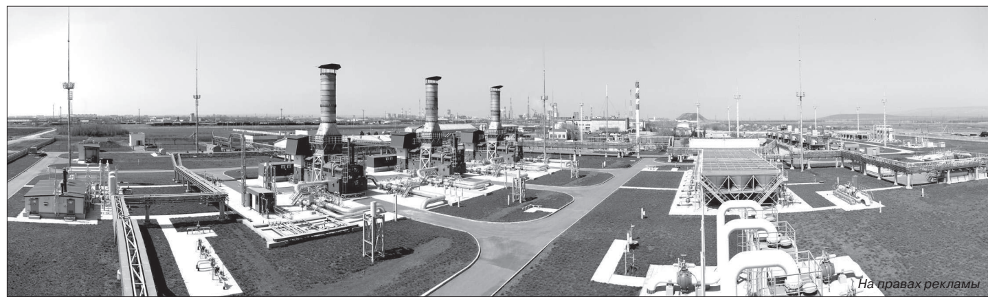
Панорама компрессорной станции «Невинномысская-3».
