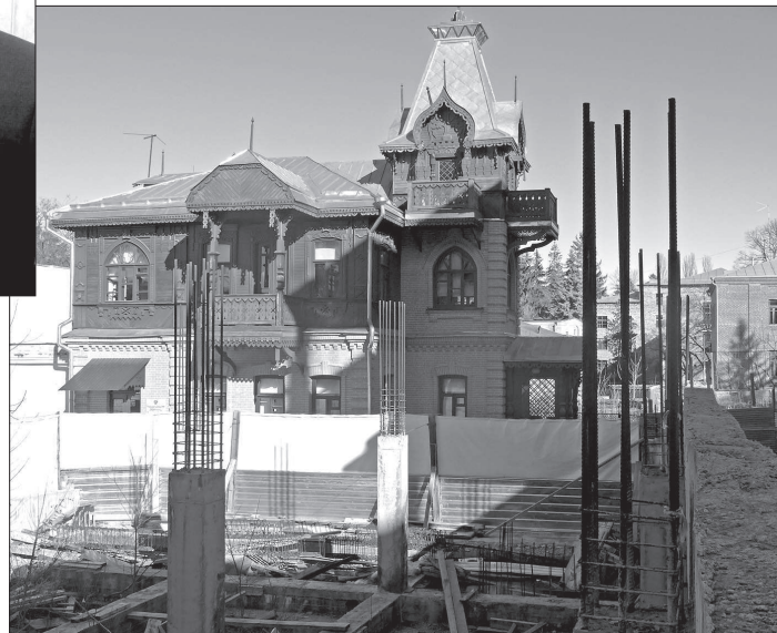
Котлованы с торчащей из них арматурой почти вплотную подступают к музею Солженицына.
