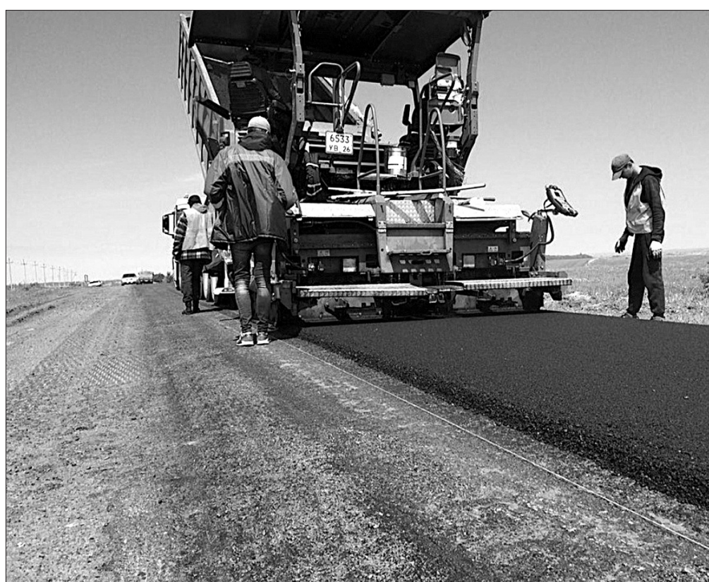
Ремонт дороги Ставрополь - Демино - Холодногорский - Цимлянский в Шпаковском районе.
