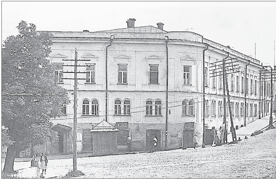
Здание Ставропольского окружного суда.
