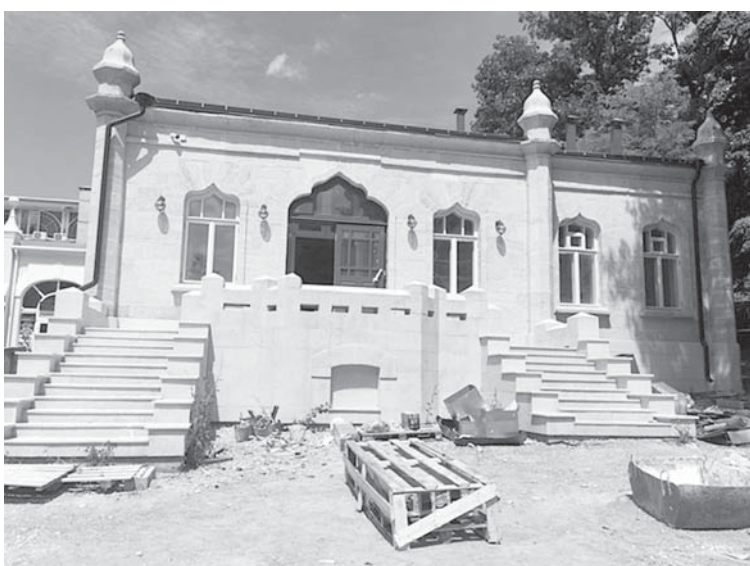
Ремонт интерьеров галереи источника № 17, Ессентуки.
