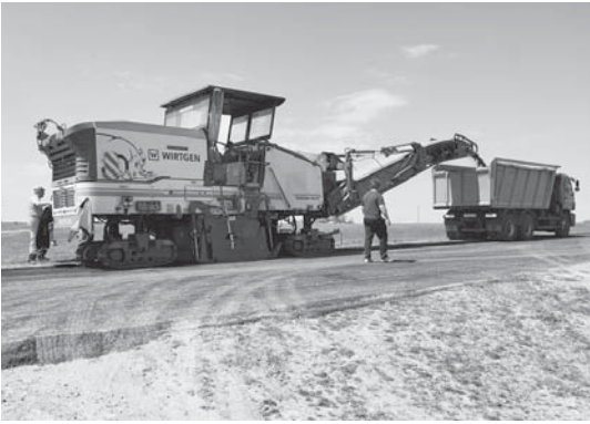
Работы по реконструкции моста местного значения в селе Рагули Апанасенковского округа. Фото: администрация Апанасенковского округа.
